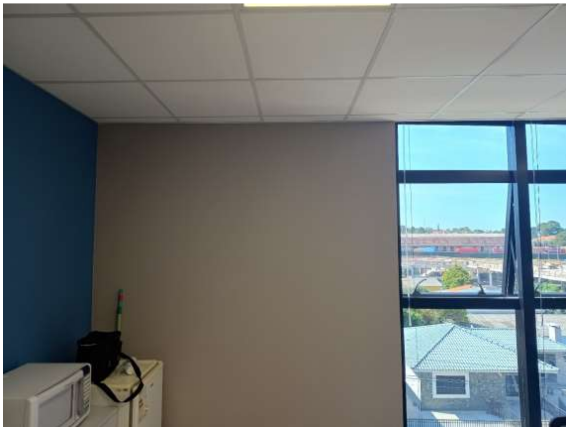
Imagem 1 - Forro do local de instalação das evaporadoras
